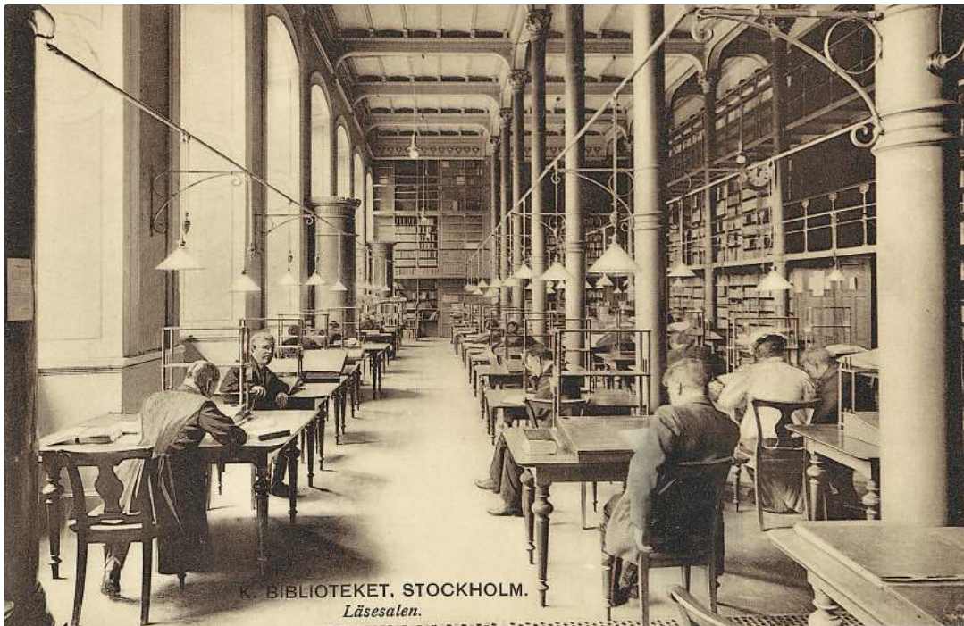
FIGUR 1. Kungliga biblioteket i Stockholm är ett exempel på en av de stora institutionsbyggnaderna som tidigt försågs med centralvärme. I läsesalen tornar höga ångkaminer upp sig vid fönstren. I förgrunden syns även galler genom vilket varm luft strömmade ut. KÄLLA: KB fotosamling, okänd fotograf, reproduktion J. Östman.
