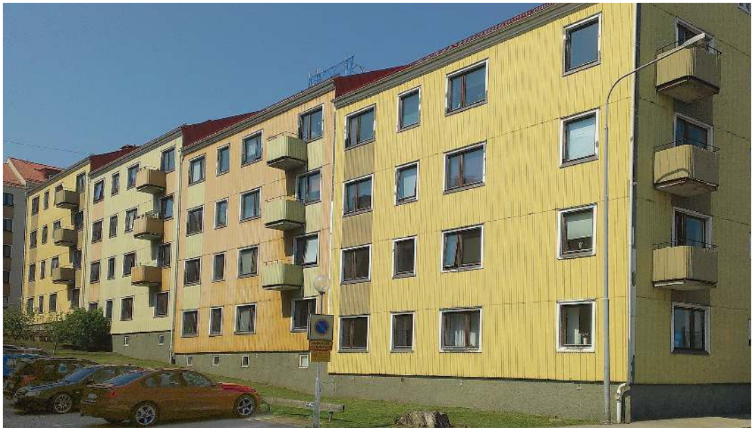
FIGUR 5. Under 1970- och 80-talens energieffektiviseringsprogram försågs många bostadshus med tilläggsisolering och nya fönster som ausevärt förändrade byggnadernas karaktär. FOTO: Edith Lalander-Malmsten/REKO.
